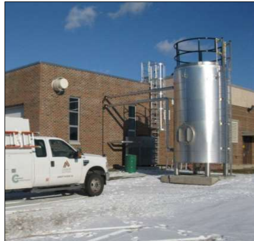
Wausau WWTP, WI
