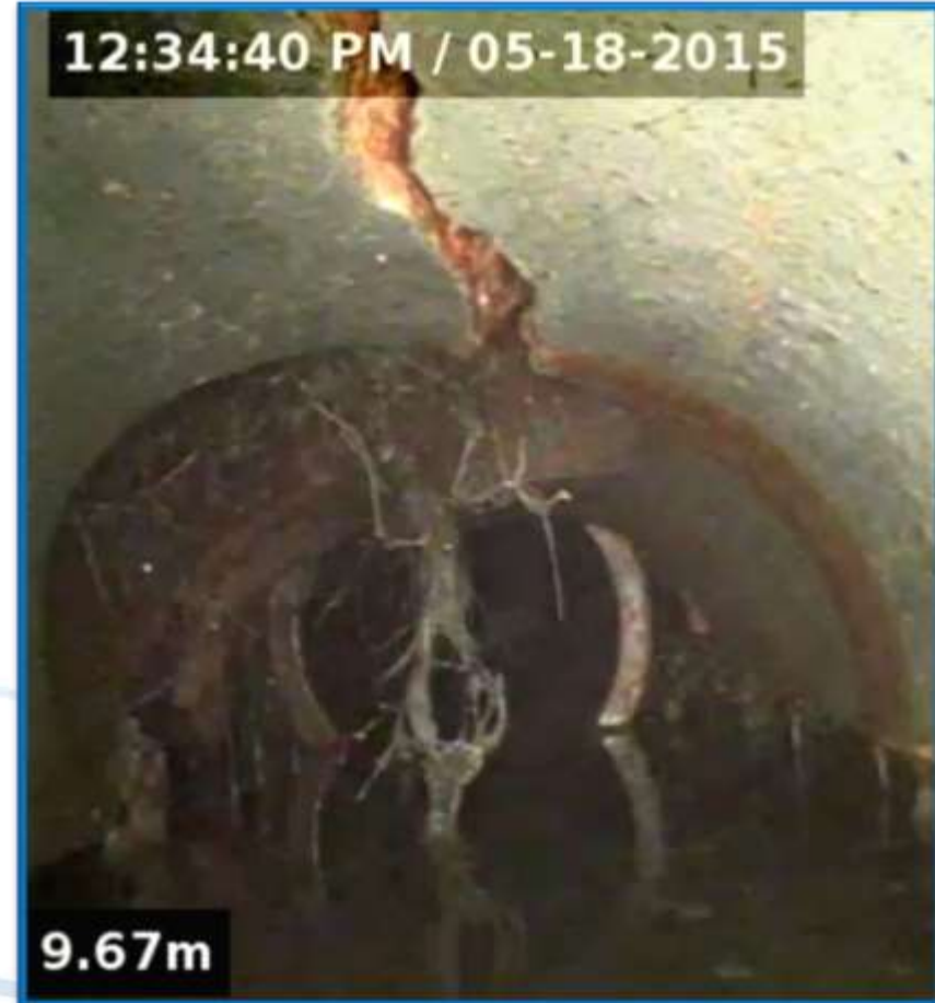
Longitudinal Cracking
