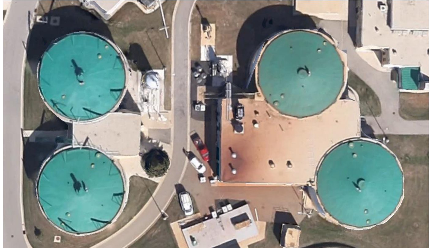
Anaerobic digesters – Fond du Lac, WI
